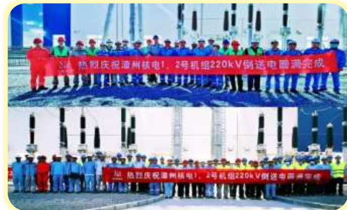
2022年7月31日，漳州1号机组220kV倒送电完成
