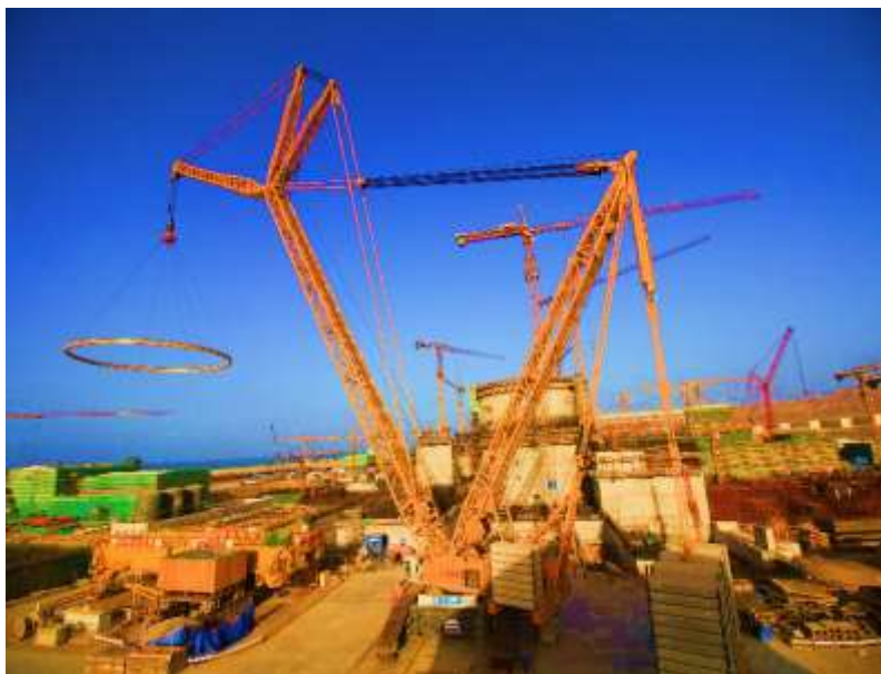
环吊环梁、环轨整体吊装
