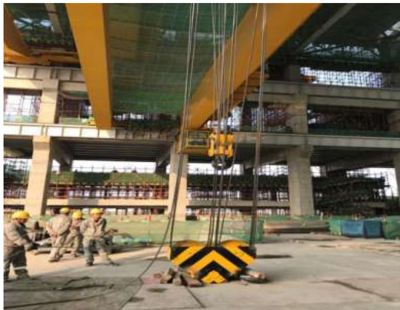
原有高空钢丝绳穿装施工工艺
