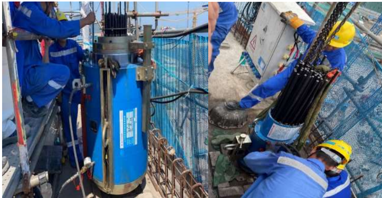
现场张拉作业（上图）
