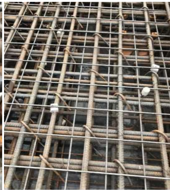
楼板增加抗裂钢筋网片
