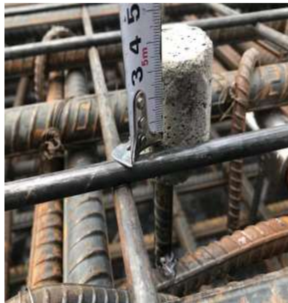
楼板抗裂钢筋网片保护层控制
