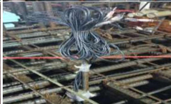
楼板混凝土温度实时监测
