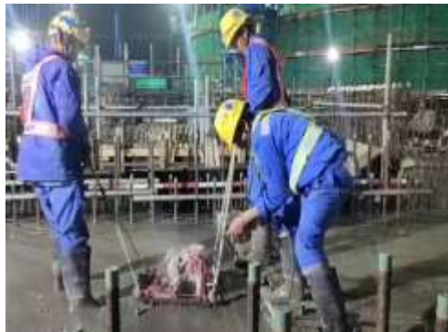
增加混凝土表面二次振捣
