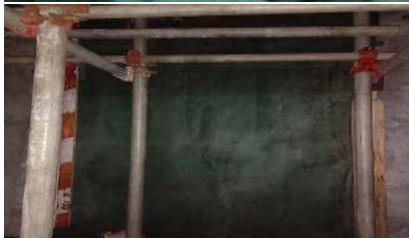
养护棚及洞口封堵施工
