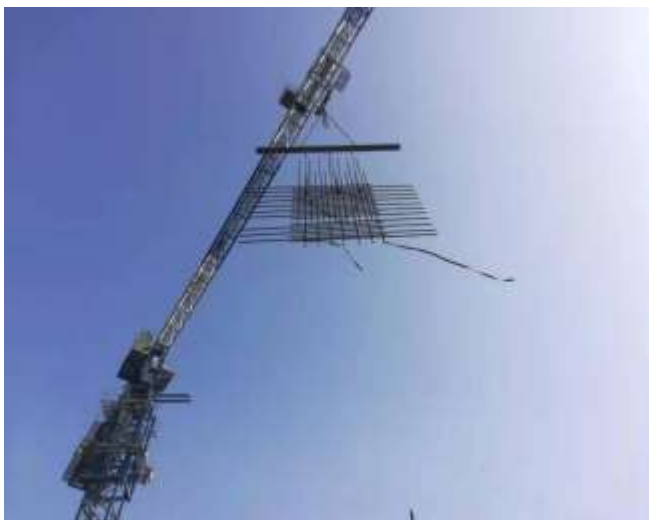
福清钢筋网片施工
