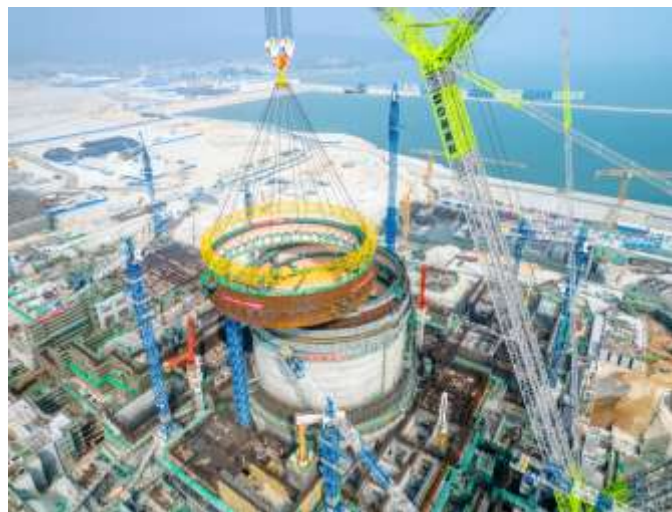
漳州钢衬里模块化吊装
