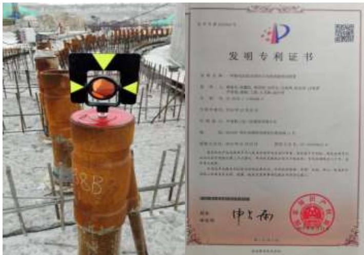
竖向预应力导管定位工装
