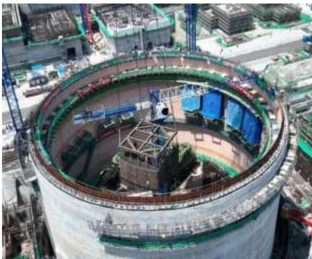
漳州钢筋墙体整体模块化施工
