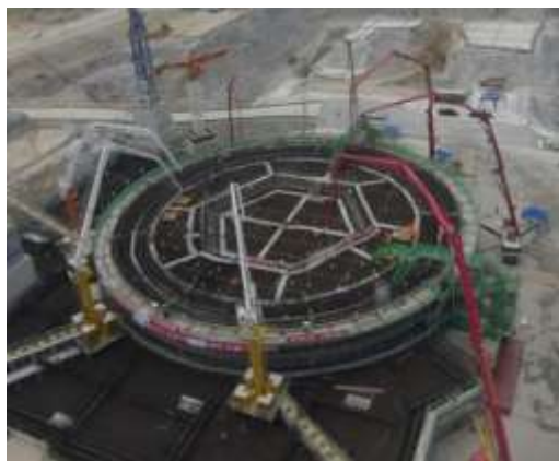
筏基大体积混凝土浇筑
