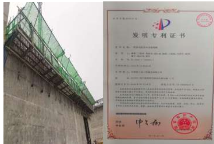
外挂架作业平台工装
