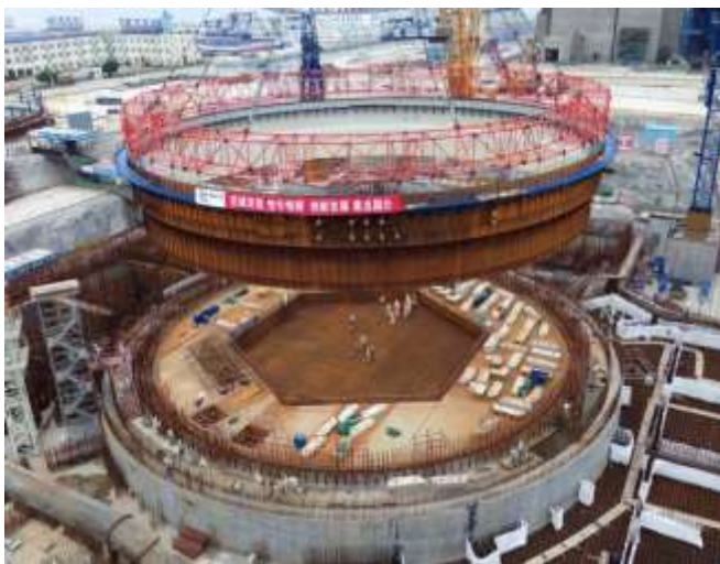
福清钢衬里模块化吊装
