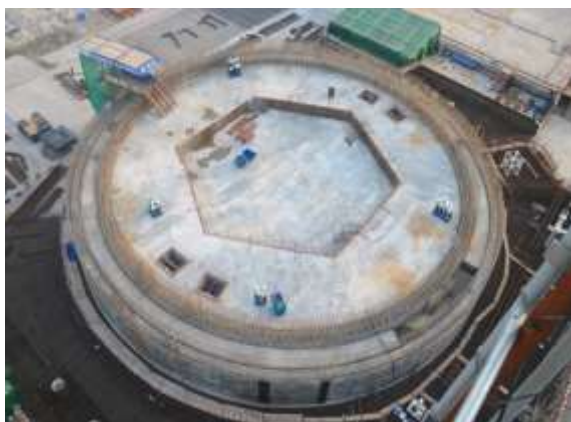
筏基大体积混凝土浇筑完成拆棚
