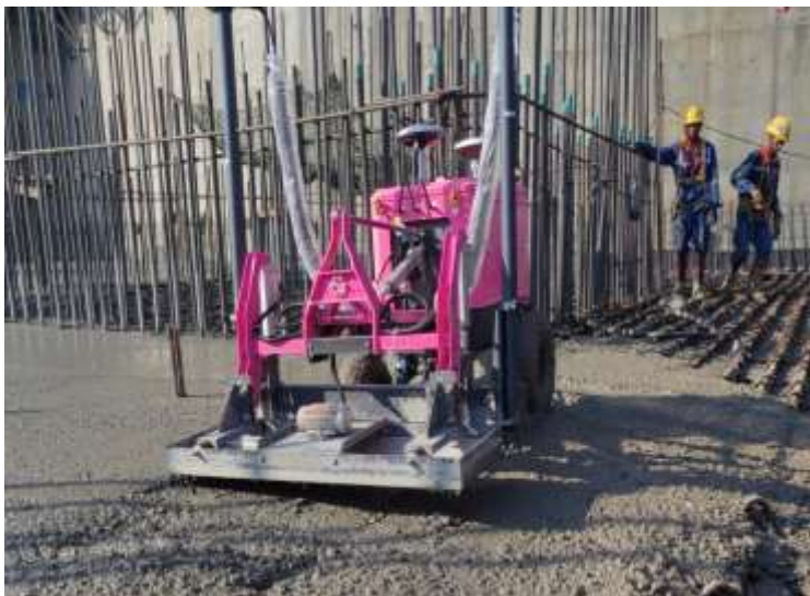
混凝土抹面机器人
