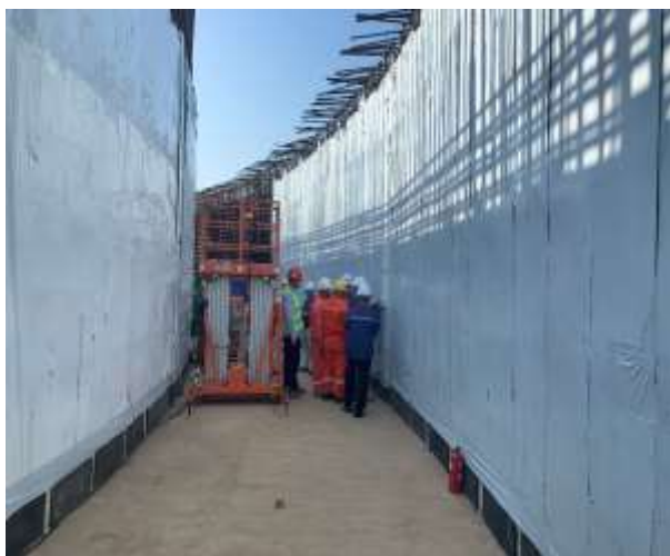
不锈钢侧壁模块化先贴法
