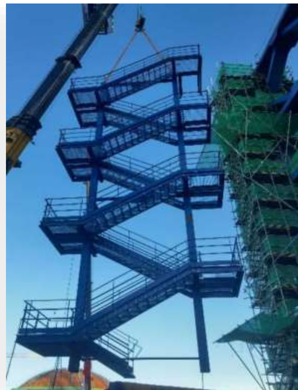
华龙一号二次钢结构示意图
