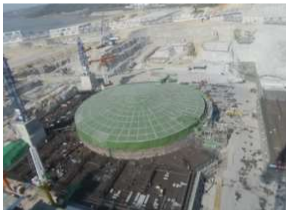
筏基大体积混凝土养护
