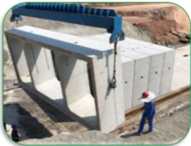
现场拼安装 沟道模块化施工
