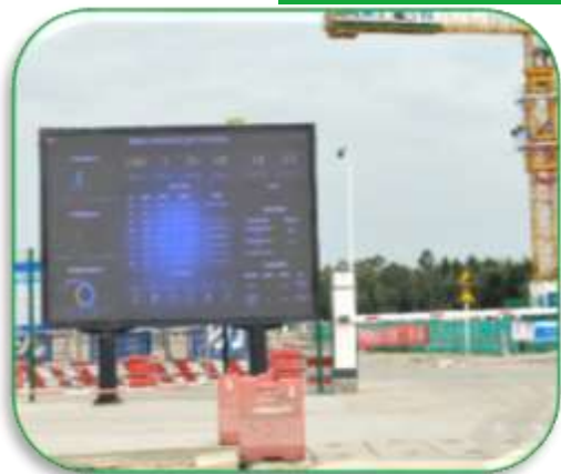
工地综合管控
