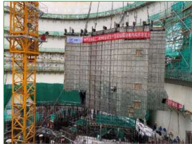
堆内构件存放池
