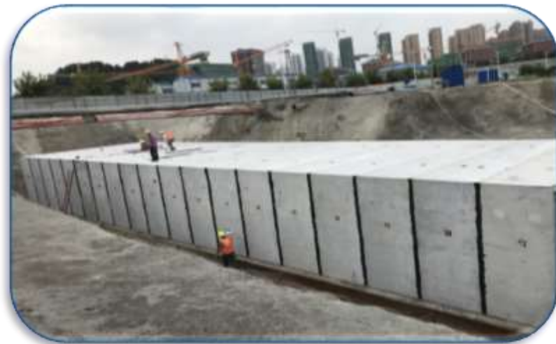
预应力张拉、防水处理
