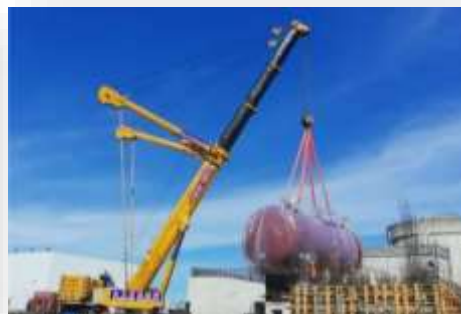
大亚湾新增柴油机项目
