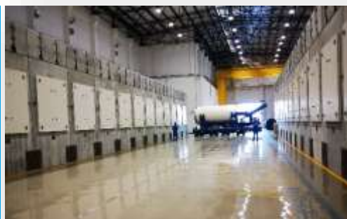
大亚湾乏燃料干法贮存 示范项目
