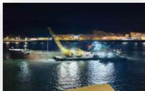
阳江核电循环水监测与 预过滤系统改造项目
