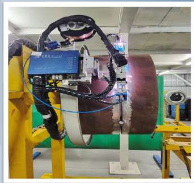
主蒸汽管道自动焊
