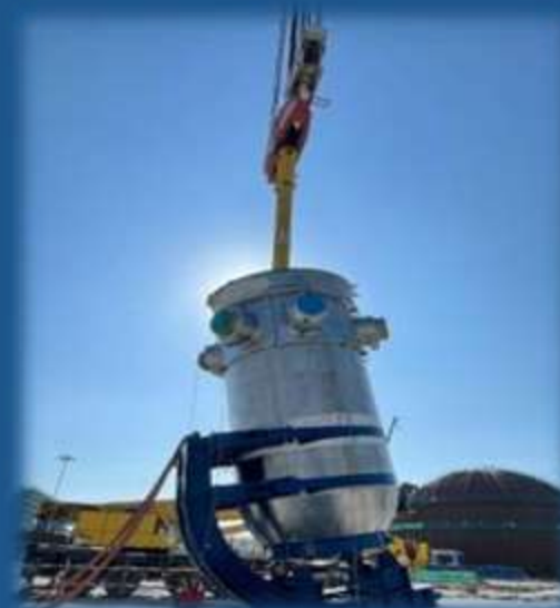
压力容器厂房外翻转
