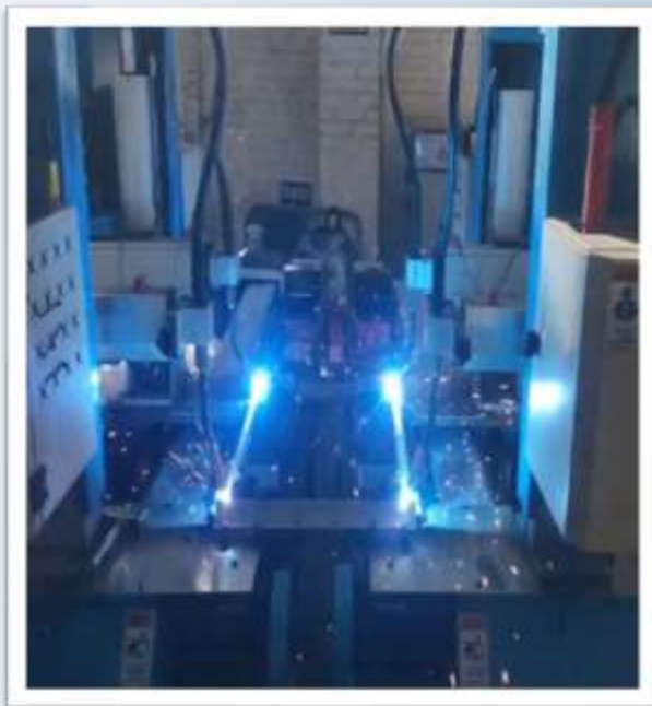
通风风管法兰焊接
