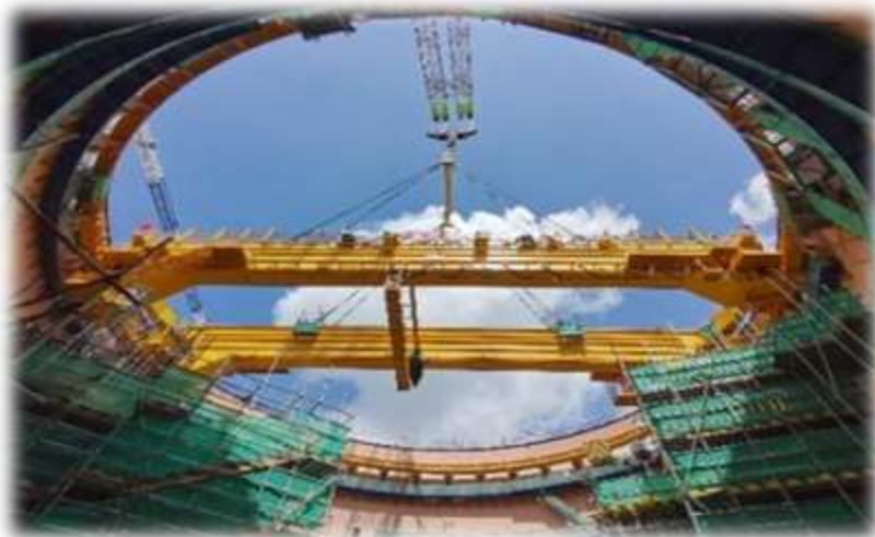
环吊桥架整体吊装
