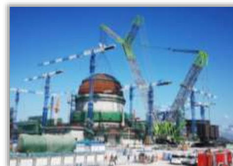
1号机组内穹顶吊装就位 2021-10-27
