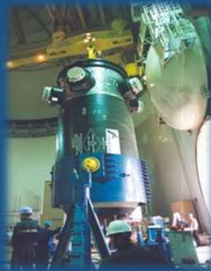
压力容器反应堆 厂房内翻转
