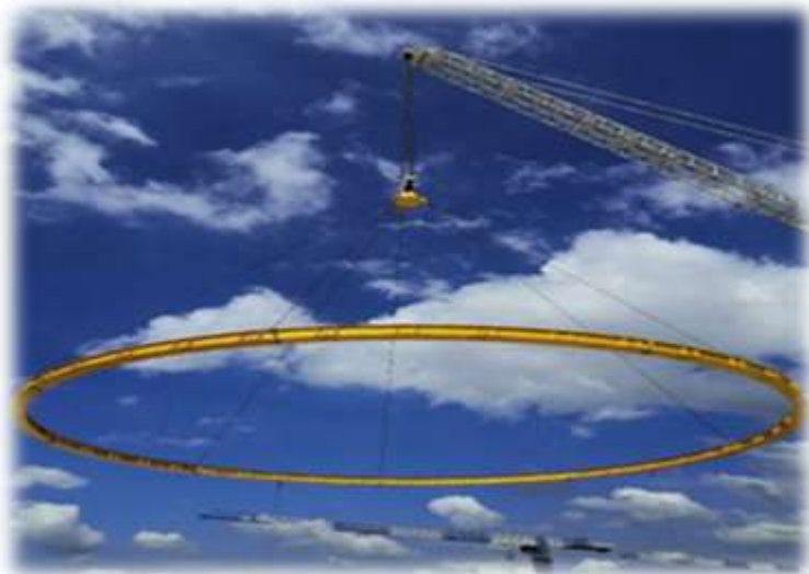
环吊轨道梁整体吊装
