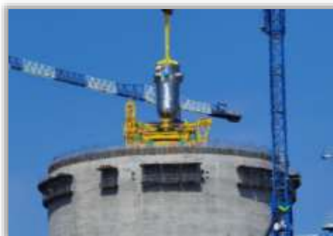
1号机组核岛主设备预引入 完成2021-10-25
