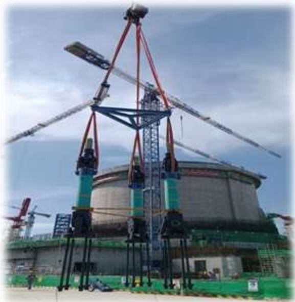
主泵垂直支承整体吊装
