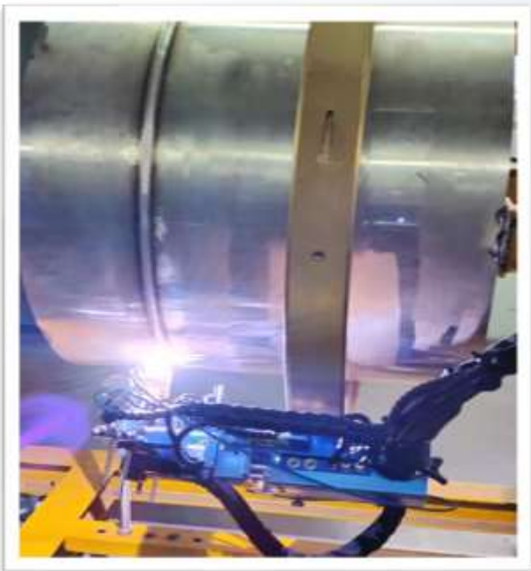
主管道国产焊机自动焊
