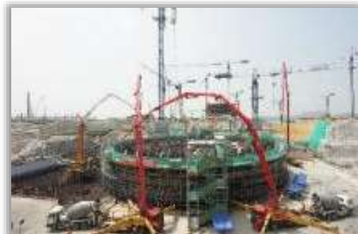
2号机组正式开工 2020-09-04
