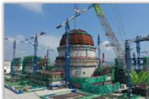
2号机组内穹顶吊装就位 2022-08-23
