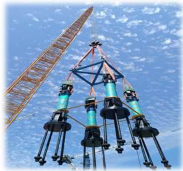
蒸发器垂直支承整体吊装
