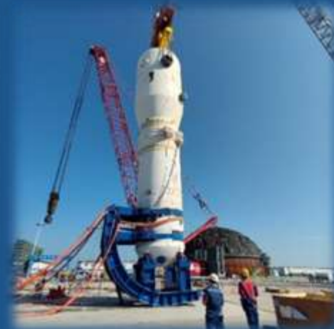
蒸发器厂房外翻转
