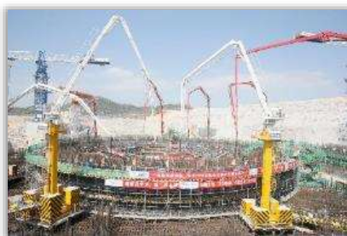
1号机组正式开工 2019-10-16
