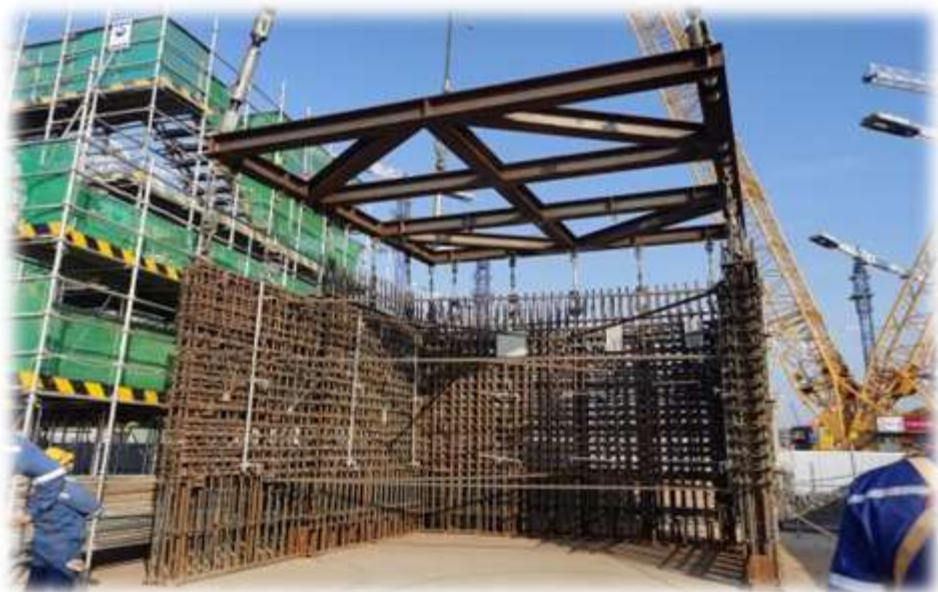
预制钢筋模块吊装
