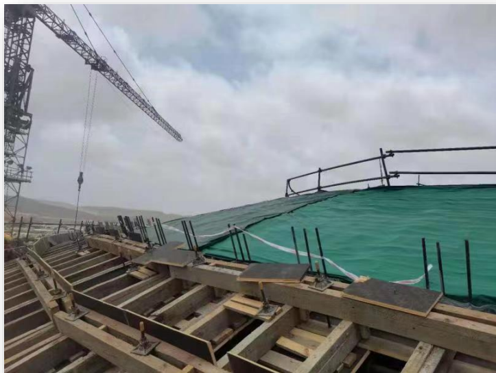
外壳混凝土未浇筑
