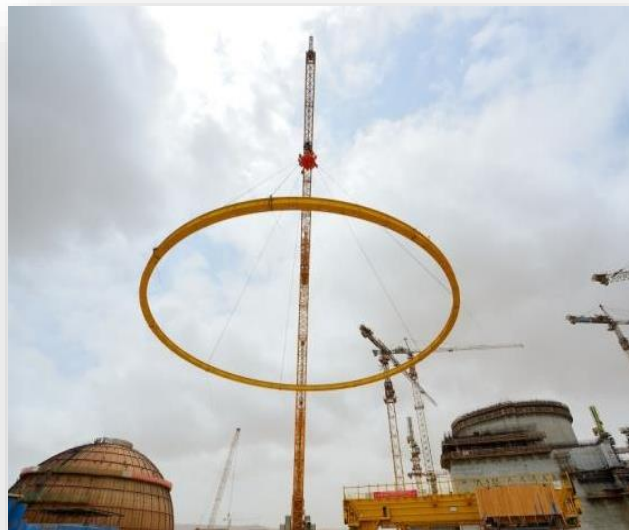
环承梁/轨道、环吊大梁整体吊装
