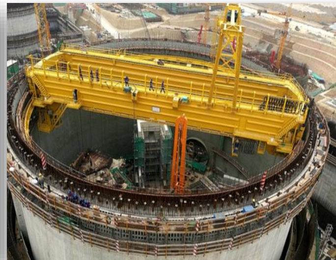
环承梁/轨道、环吊大梁整体吊装
