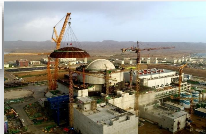
外穹顶钢模板整体吊装
