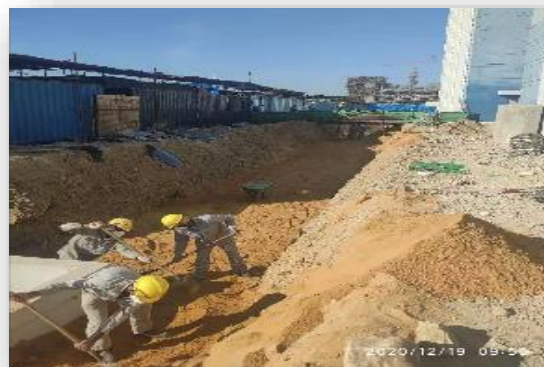
协助YA施工
