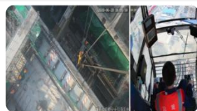
施工安全监控
