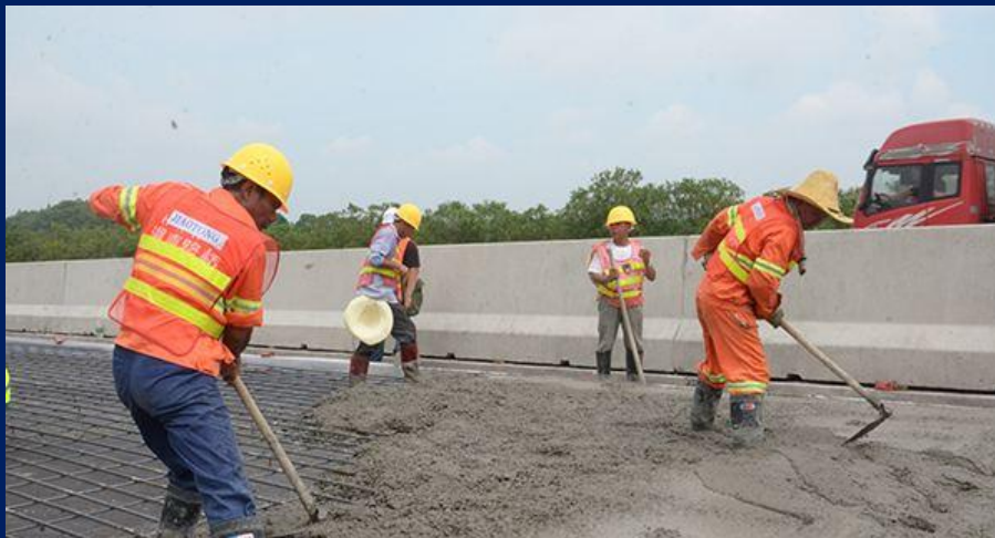
高速公路施工
