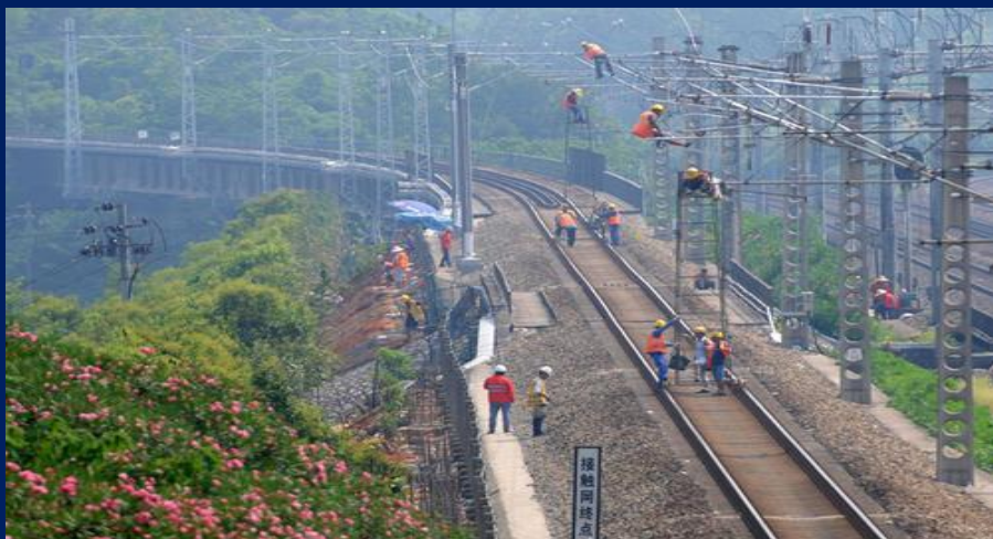
轨道交通施工
