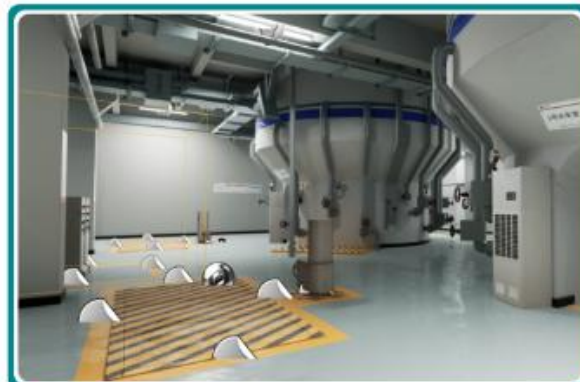
● 110KV母线检修转运行培训
