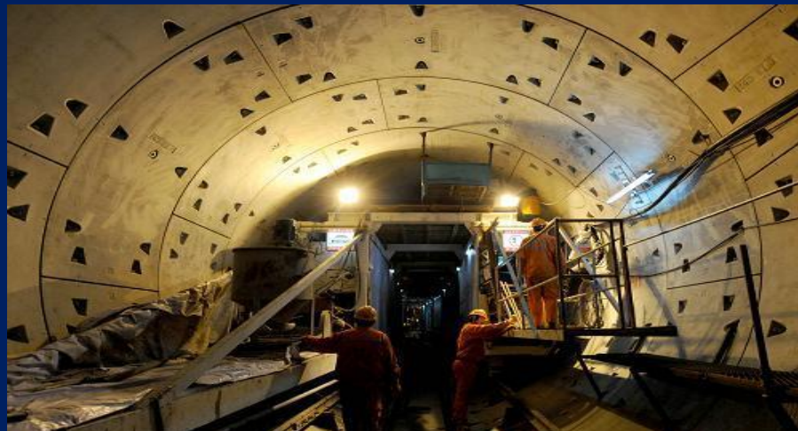
地铁隧道施工
