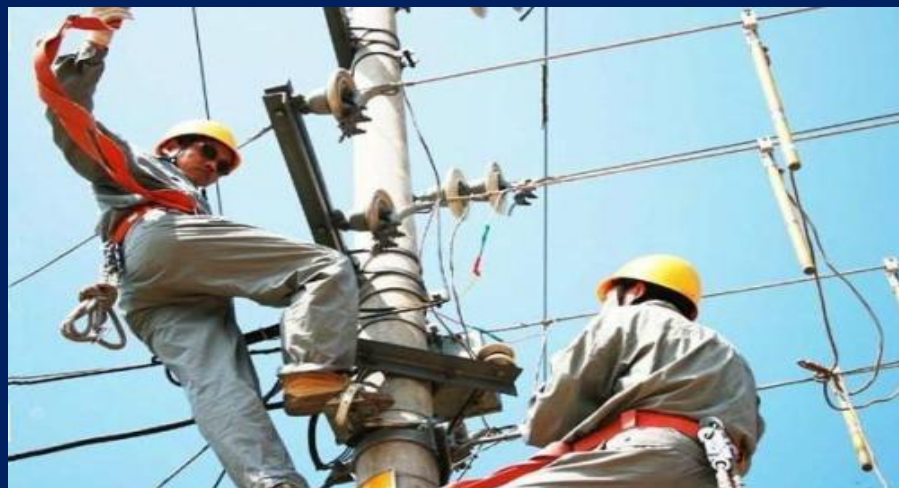
电力能源施工
