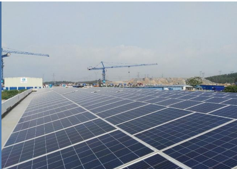
项目办公楼顶安装光伏太阳能板
