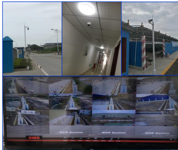
项目部及道路视频监控
