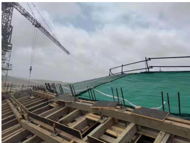
外层安全壳混凝土未浇筑
