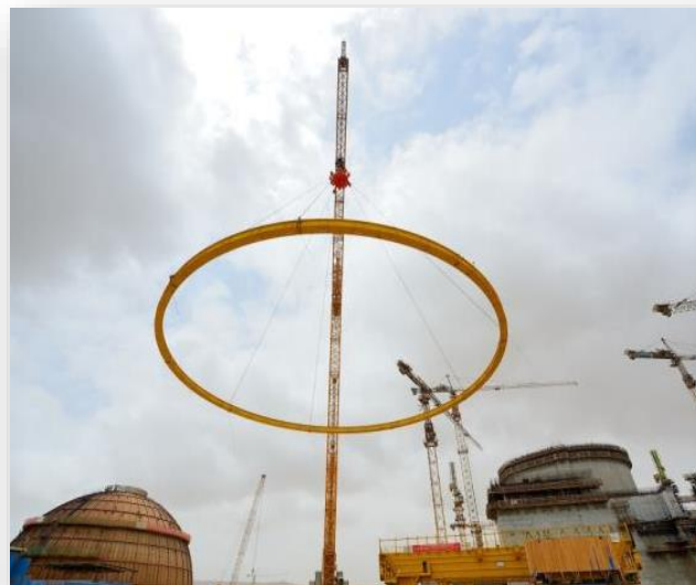
环承梁/轨道、环吊大梁整体吊装
