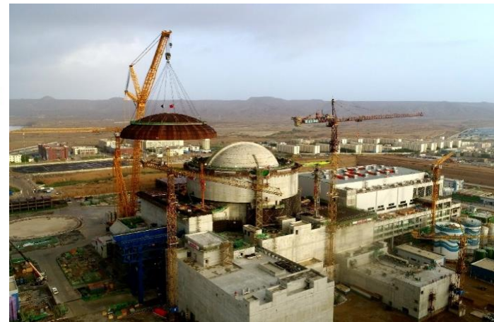
外穹顶钢模板整体吊装
