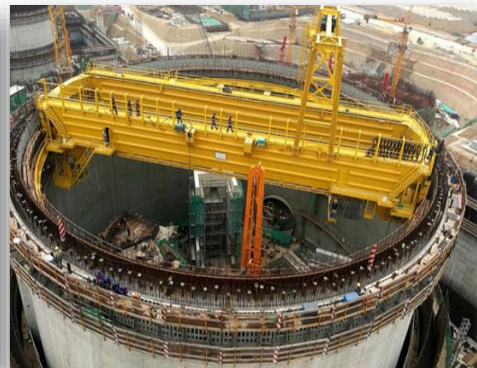
环承梁/轨道、环吊大梁整体吊装
