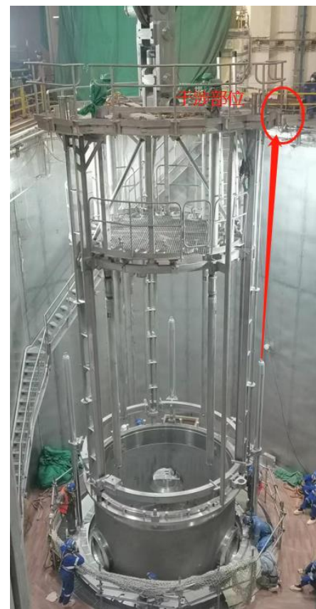
上图显示的是短导向柱，箭头指示为长导向柱安装后的高度，红圈为碰撞部位
