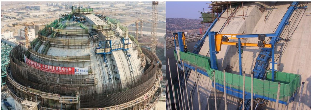
预应力施工双平台
