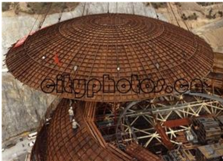
秦山核电穹顶模块吊装
