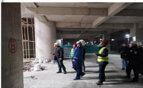
现场安全巡检
