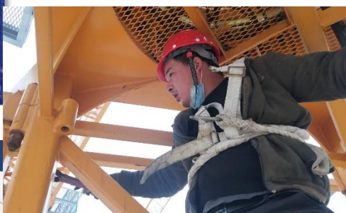
塔吊设备检查
