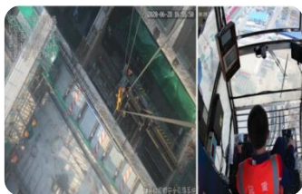
施工安全监控
