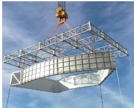
内置换料水池模块吊装图
