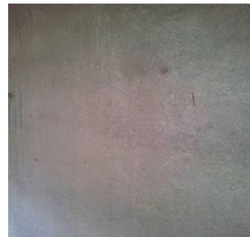
混凝土整体表面平整
