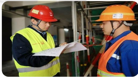
现场方案一致性及质量网格化检查
