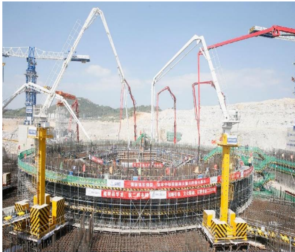
2019年10月16日,1号机组核岛第一罐 混凝土浇筑开始 ( FCD )
