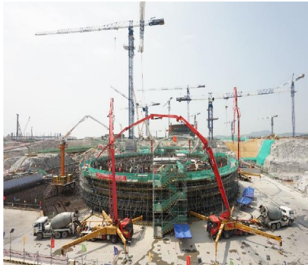
2020年9月4日,2号机组核岛第一罐 混凝土浇筑开始 ( FCD )
