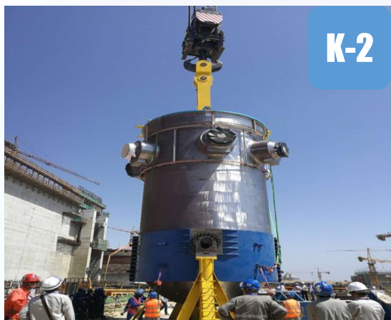
K-2机组反应堆压力容器预引入
