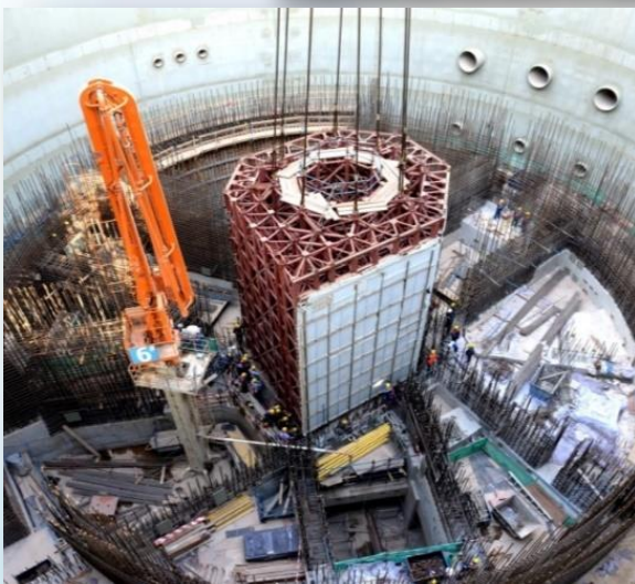
2017年2月，K-2机组堆腔水池模块吊装就位
