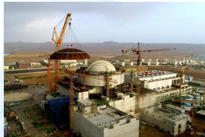
外穹顶钢模板整体吊装
