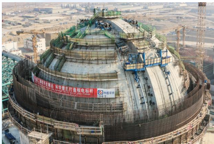
预应力施工双平台
