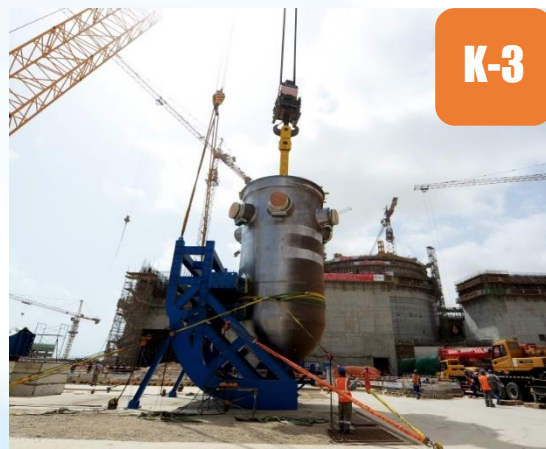
K-3机组反应堆压力容器预引入
