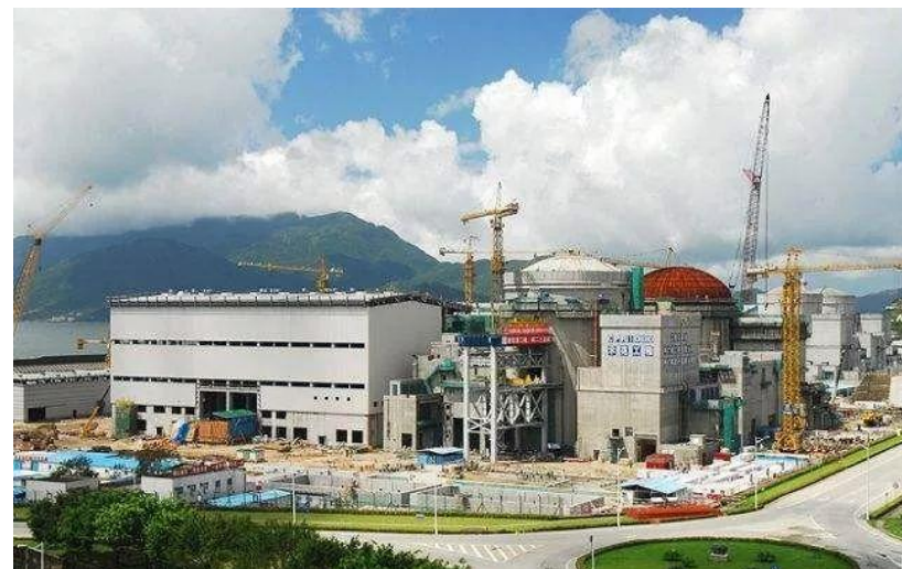
石岛湾核电项目
