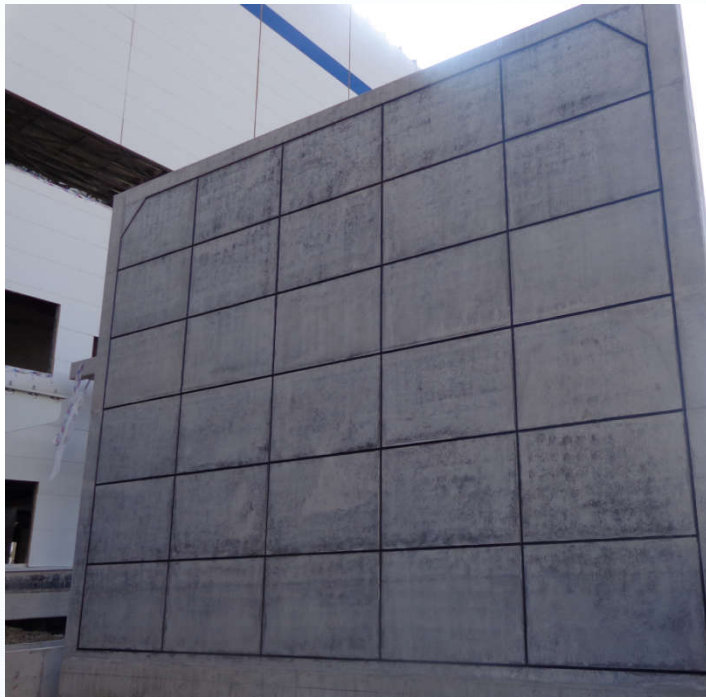
某国优工程电厂防火墙清水混凝土效果
