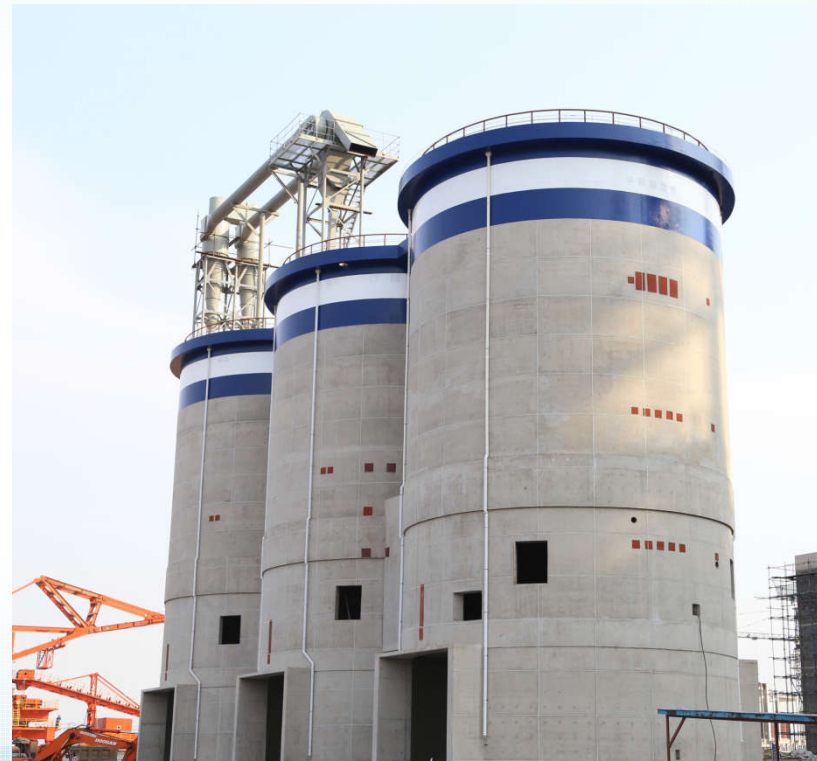
某国优工程电厂灰库表面清水混凝土效果
