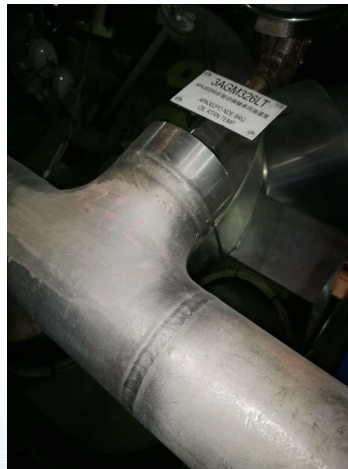
阳江核电项目常规岛部分焊缝成型美观，表面光洁
