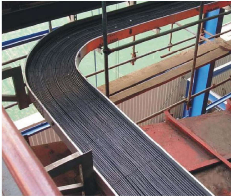
华能巴基斯坦萨希瓦尔电站--国优金奖工程电缆敷设
