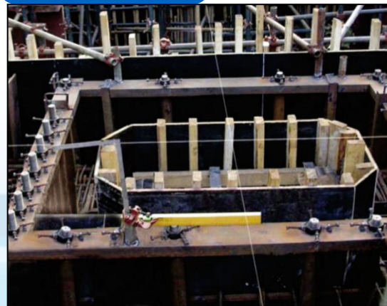
螺栓固定钢架定位工艺
