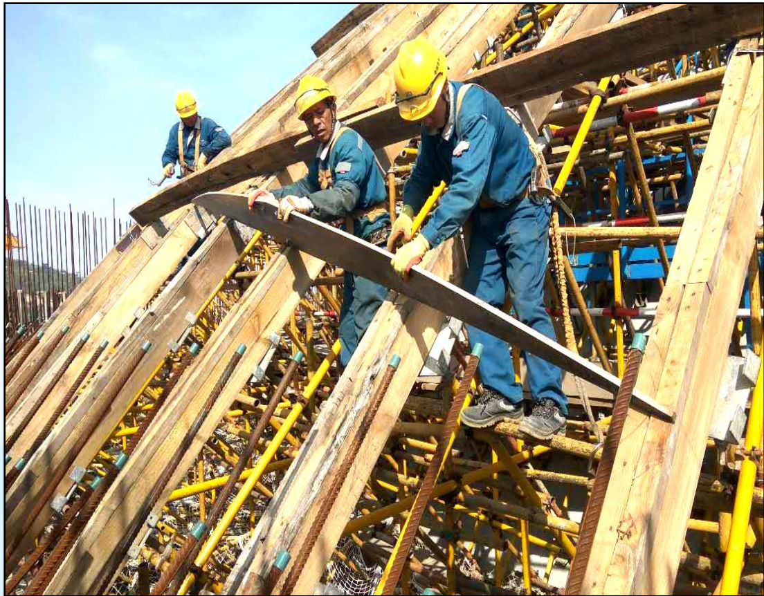
安全壳穹顶模板使用样板检查
