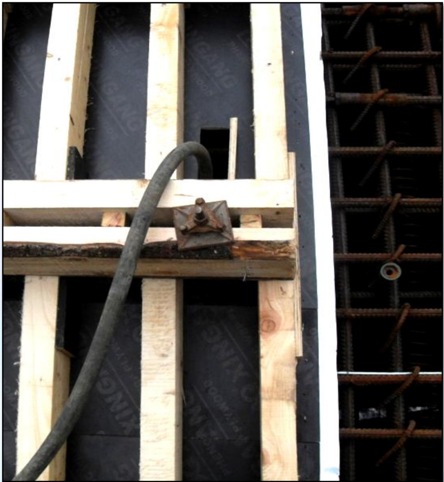
结构复杂区域模板开设振捣口
