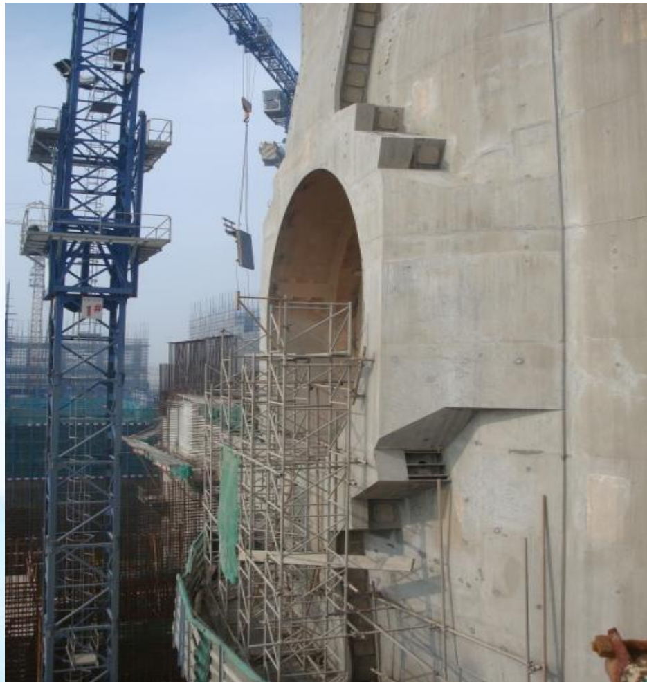
安全壳筒身模板现场安装
