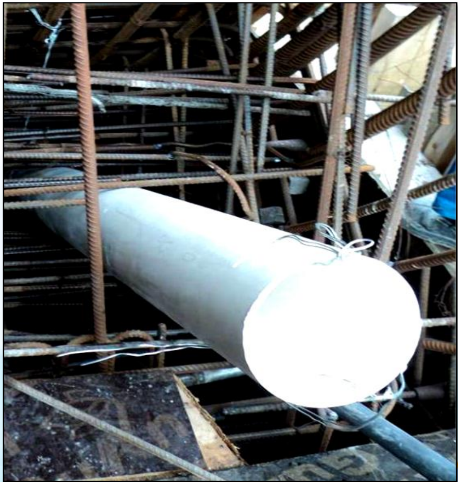
钢筋密集区域设置溜槽
