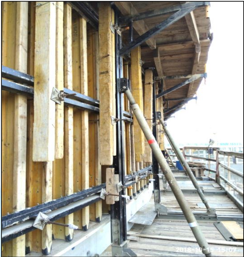
安全壳筒身模板现场安装
