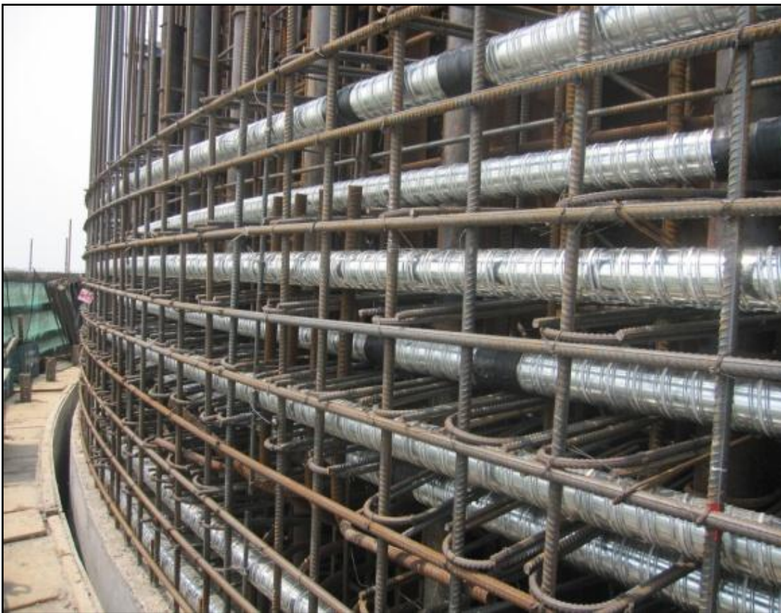
安全壳筒身钢筋/预应力管道安装
