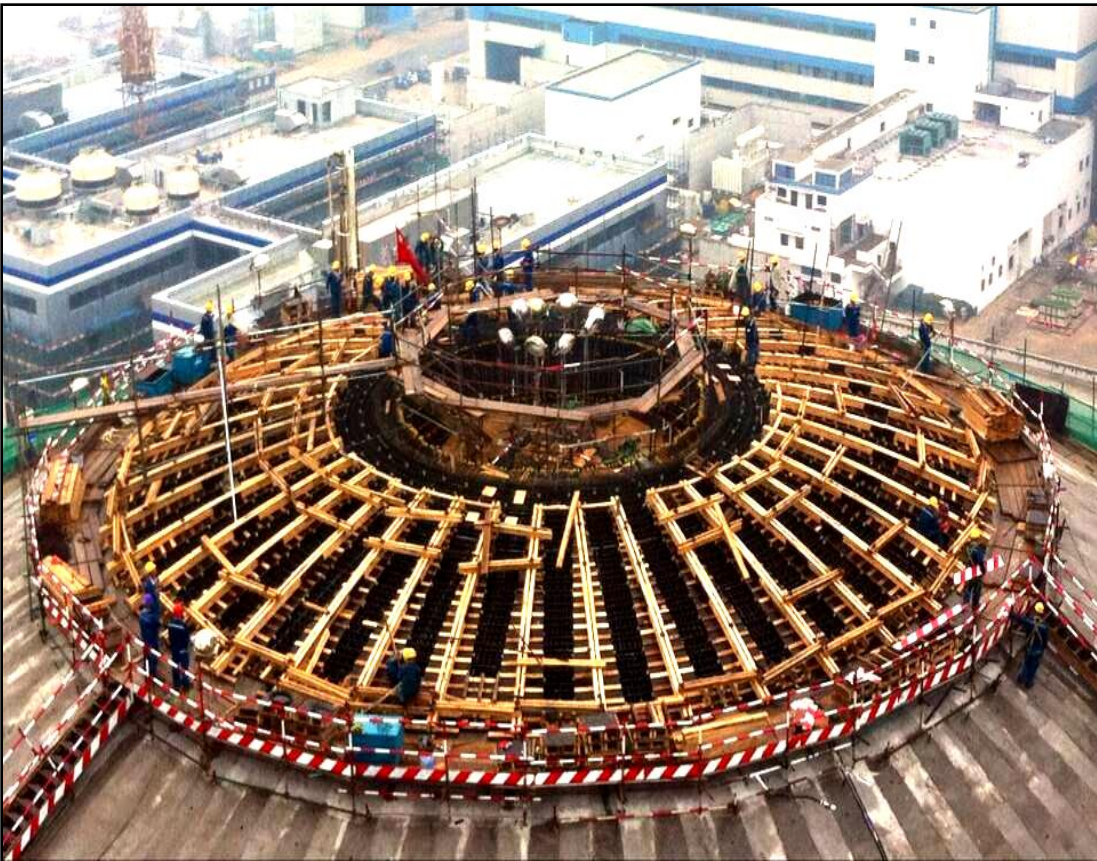
安全壳穹顶模板工艺
