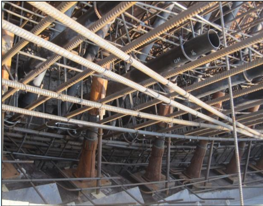
预应力锚固件安装
