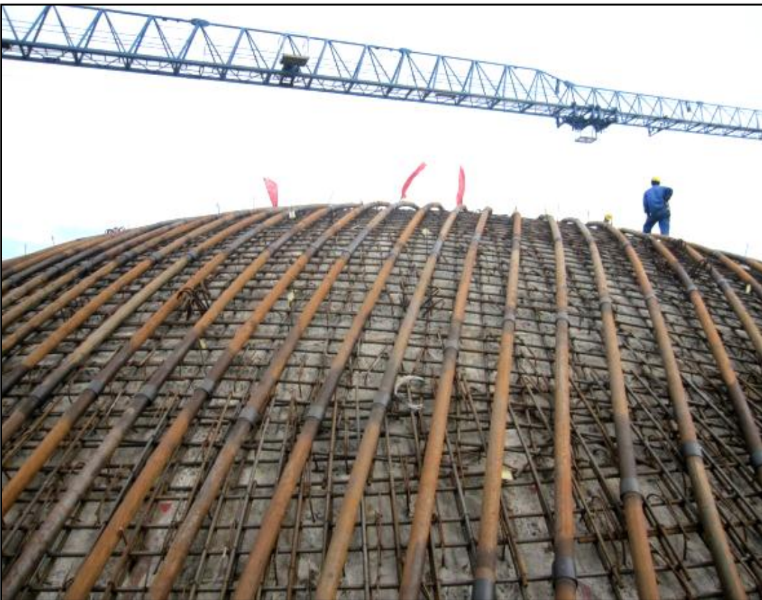
安全壳穹顶钢筋/预应力管道安装
