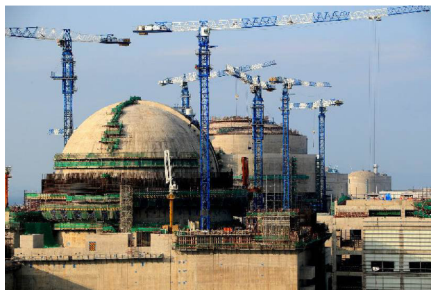
图9 福清核电厂5、6号机组工程建造现场
