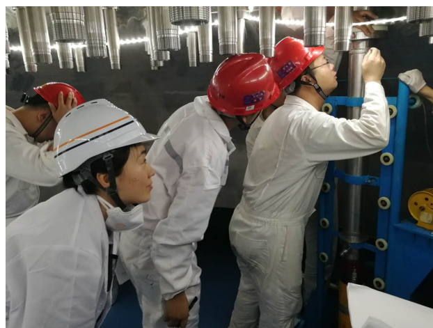
图 6 监督员见证红沿河核电厂 5 号机组控制棒驱动机构密封焊水压试验后渗透检验
