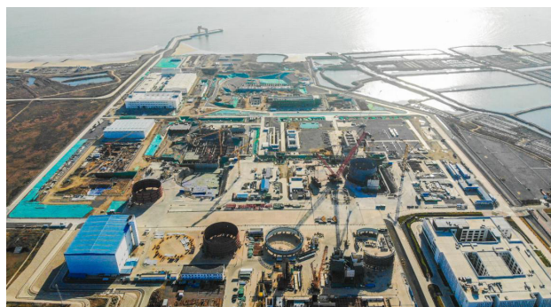
图 17 国核示范工程建造现场
