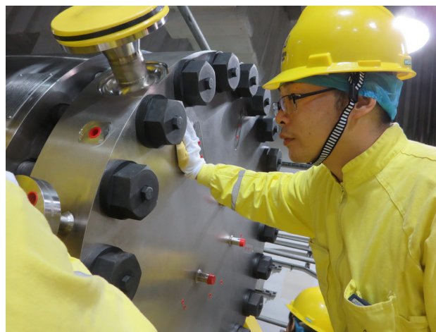
图 13 监督员在三门核电厂 2 号机组辐射控制区对进口新主泵开箱进行现场监督
