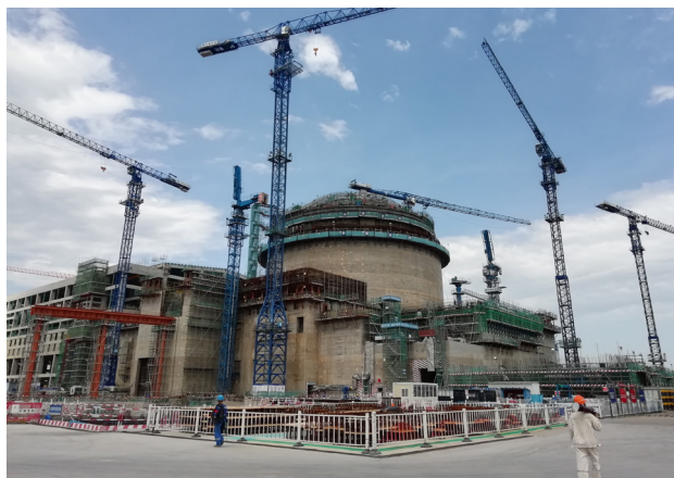
图12 防城港核电厂3号机组工程建造现场
