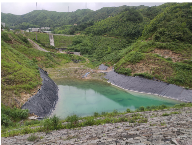
图 23 尾渣库防渗设施
