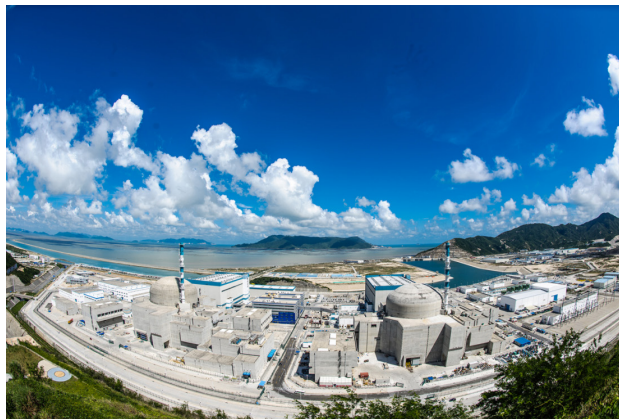
图 15 台山核电厂全景
