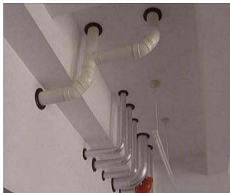
4.9 穿套管安装效果照片
