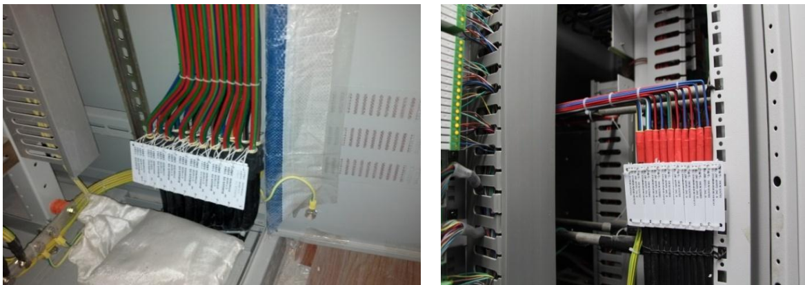
12.4 电缆标牌安装效果照片
