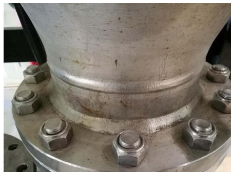
4.8 法兰安装效果照片
