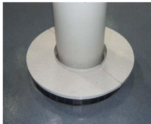
4.9 穿套管安装效果照片
