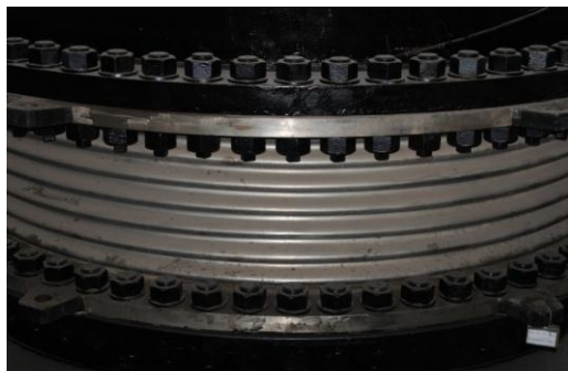
4.8 法兰安装效果照片
