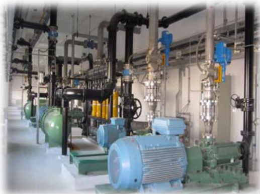
海淡厂房水泵油漆
