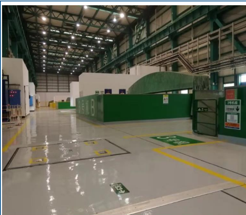
泵站地面采用环氧砂浆地坪漆，强度高，耐磨及易维护
