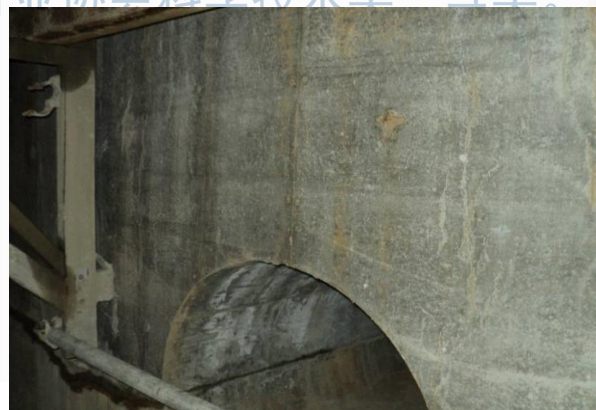
贯穿件处混凝土密实
