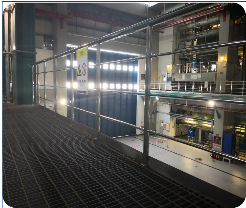
不锈钢栏杆制作安装工艺美观
