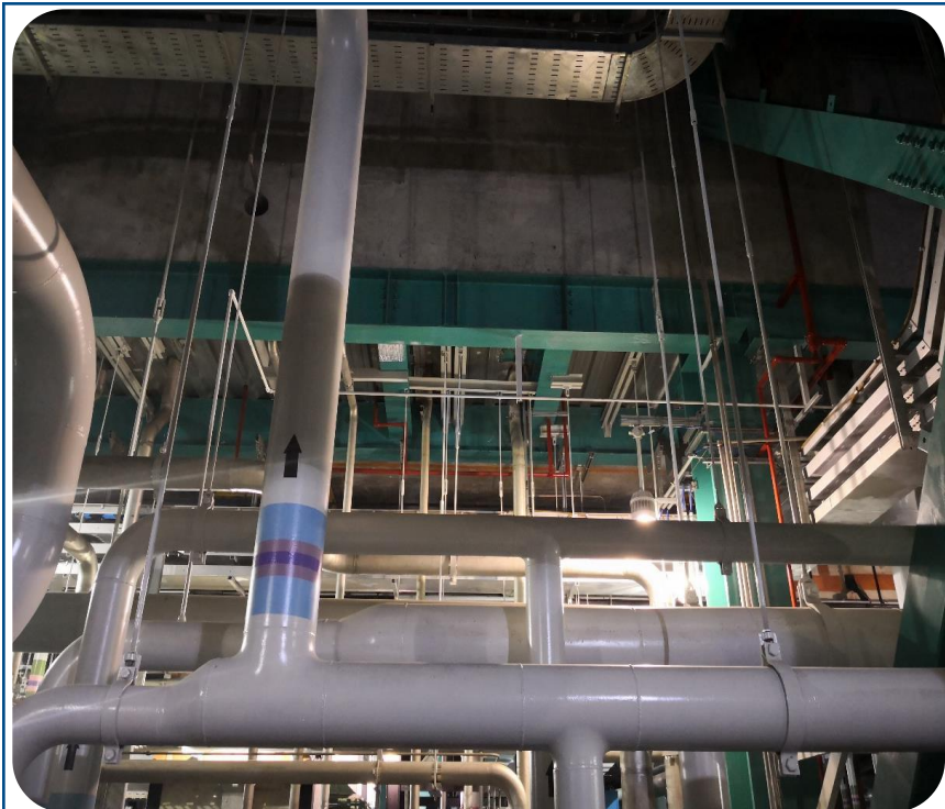
管道吊杆安装垂直，工艺良好
