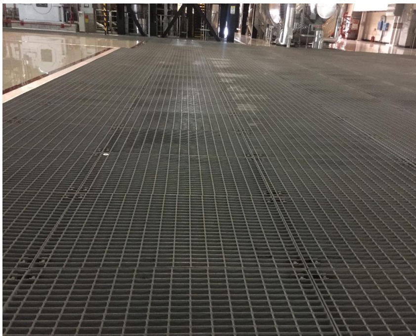
3MX钢格栅铺设安装质量好
