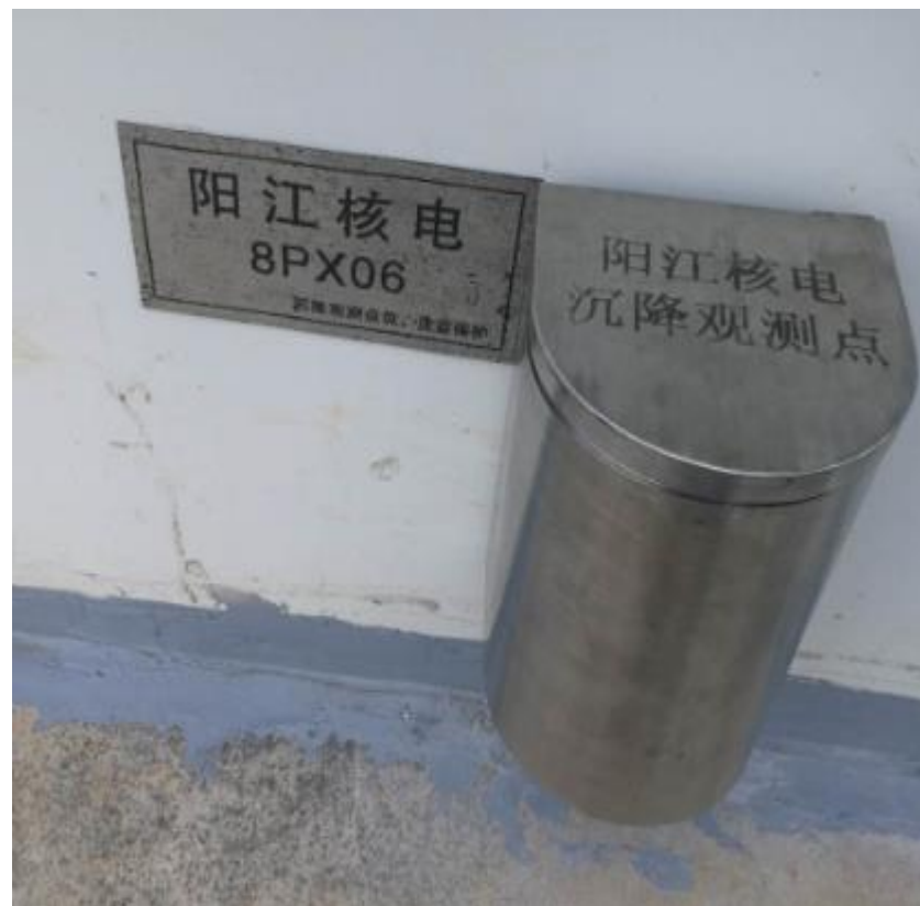
8PX联合泵房沉降观测点保护措施标准、美观
