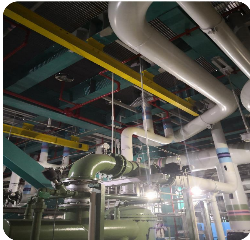
管道吊杆安装垂直，工艺良好
