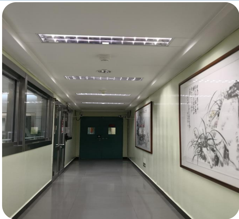
吊顶平整，缝隙均匀
