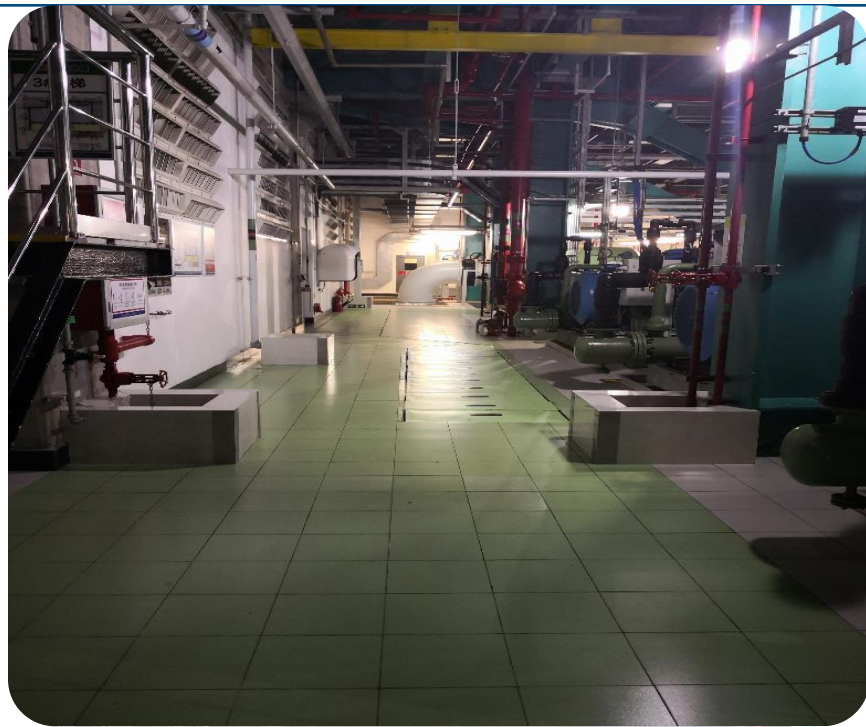
地板砖铺贴工艺美观
