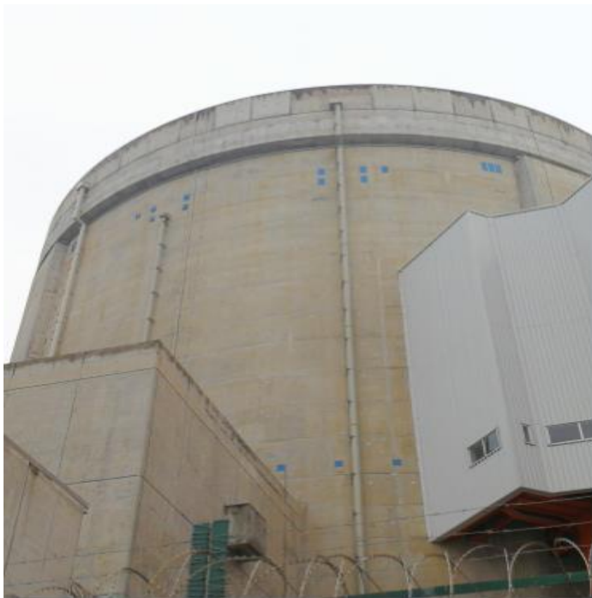
核岛厂房施工缝横平竖直
