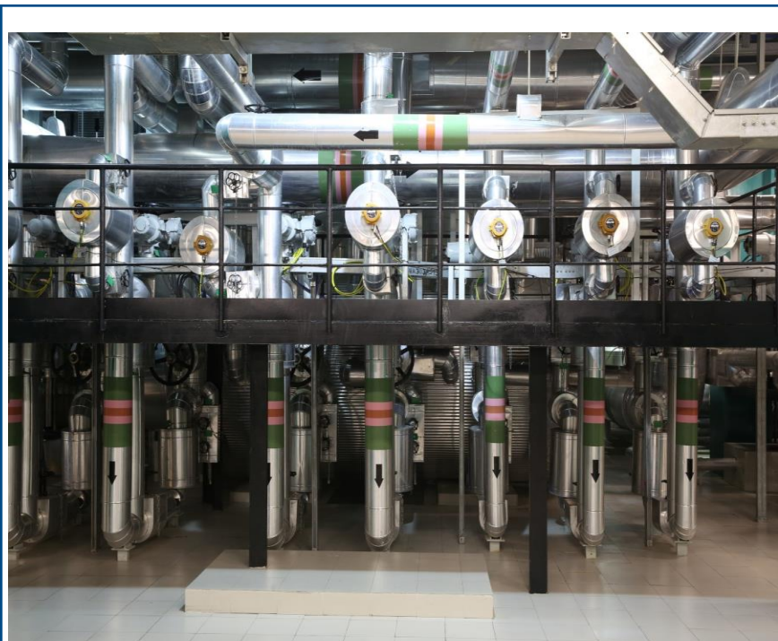
管道安装层次间距分明，工艺美观
