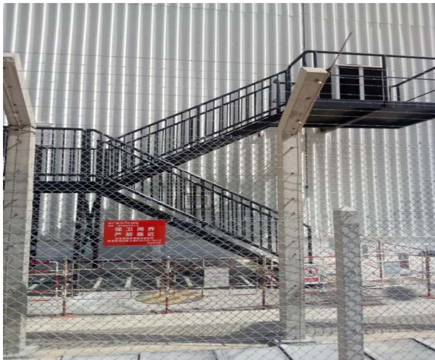
直梯改斜梯，提升安全水平
