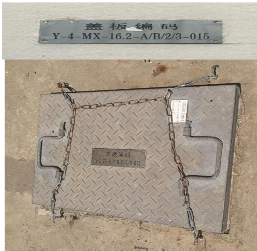
各类盖板采用便捷的链条式防台固定措施，并设置了不锈钢编码牌
