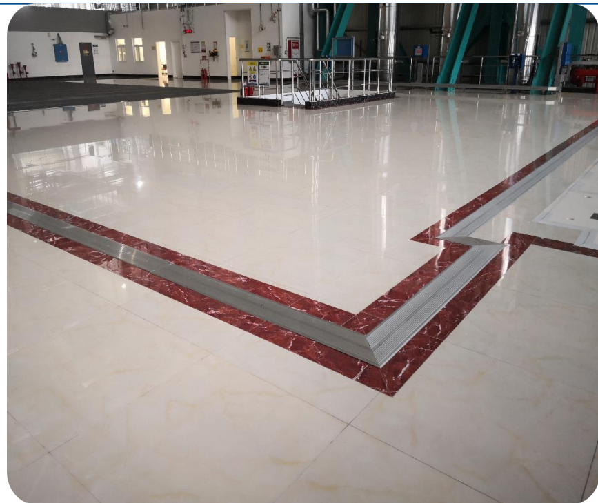
地板砖铺贴密实，灰缝均匀顺直，工艺美观
