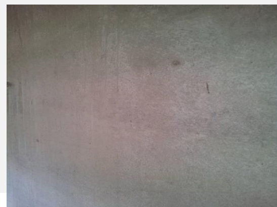
混凝土整体表面平整
