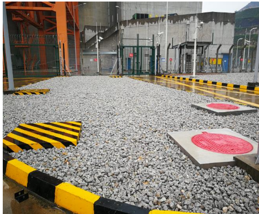
雨水检查井和消防检查井有效区分
