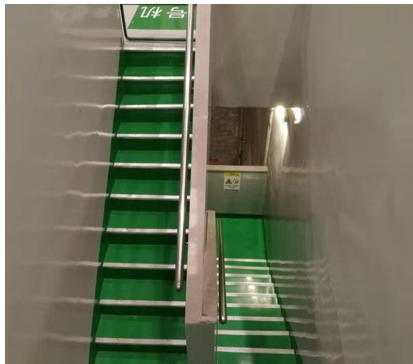
楼梯处易磕碰损坏处采取包边处理，同时达到防滑效果
