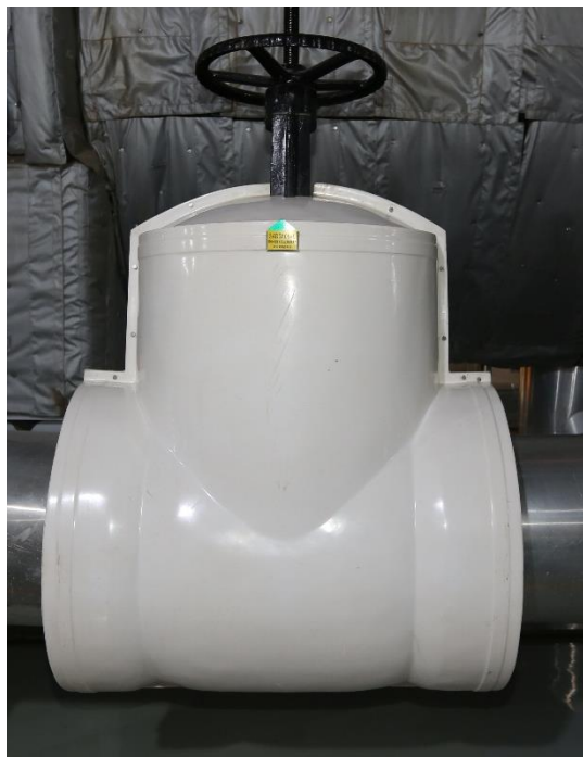
3号机组电动阀和手动阀安装
