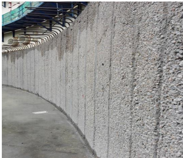
混凝土毛面墙体成型工艺 获得国家实用新型专利
