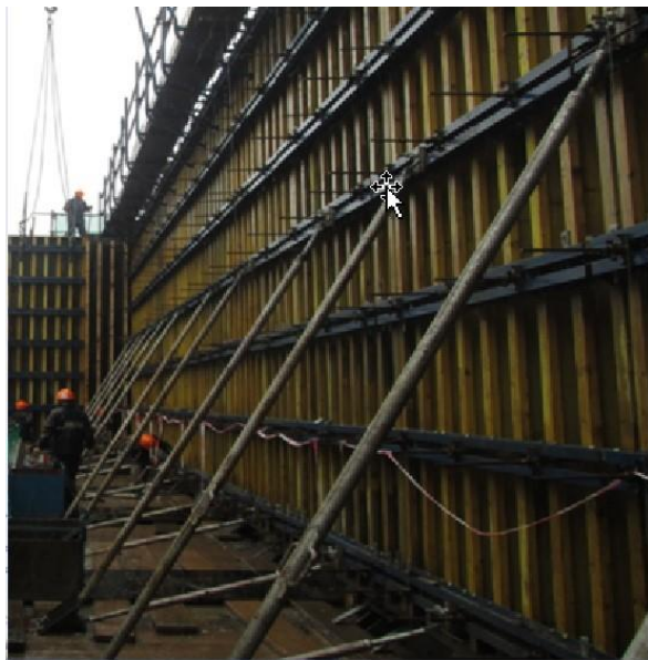
核岛直墙大模板应用
