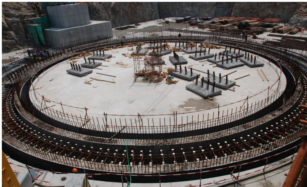
核岛反应堆厂房测量控制网 获得省级工法和国家专利
