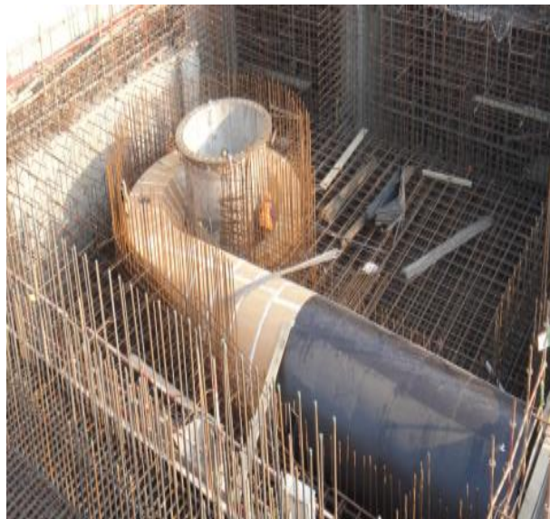
核电站蜗壳泵空腔大体积砼浇筑施工技术
