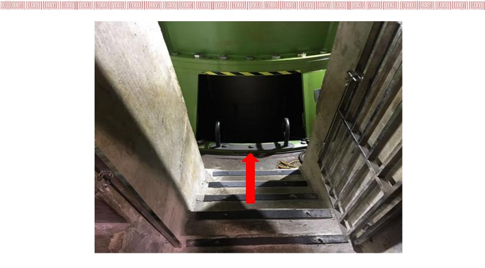
泵坑底部通道缺少护栏,人员绊倒后易落至坑底。
