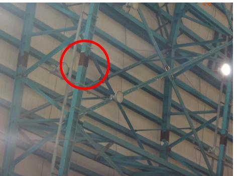
钢梁连接处未涂刷 防腐涂料; 钢梁表面防火油漆脱落, 连接处未做防腐;
