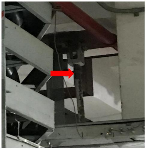
支吊梁安裝有歪斜、锁母未锁紧、罗电缆桥梁等现象;
