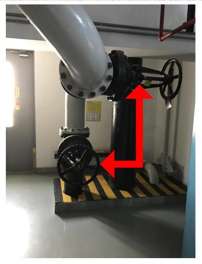
主油箱事故放油阅无警示标识、无防护装置, 手轮上锁;
