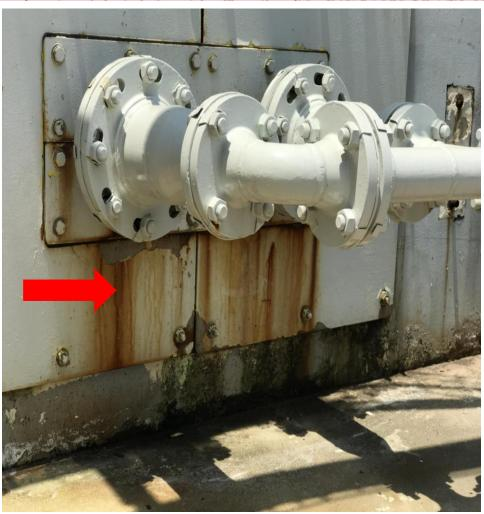
设备、管道、阀门螺栓锈蚀,有污染痕迹;
