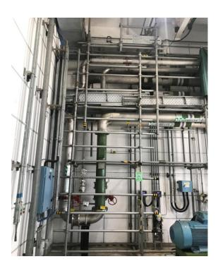
用脚手架代替围栏;脚手架标识牌填写不规范。脚手架直爬梯没有配备防坠落措施。
