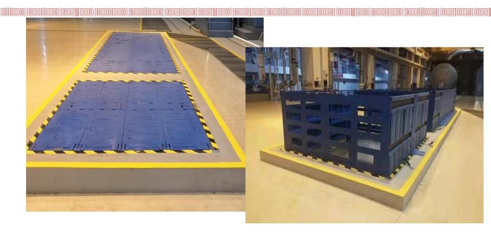
汽轮机车间竖向运输吊洞盖板设置巧妙,操作 简便,开启盖板后可兼做防护栏杆, 关闭盖板 后, 地面平整。
