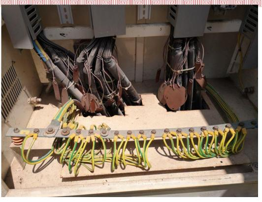
现场保护套管、电缆敷 设及机柜内电缆施工工 艺欠佳。
