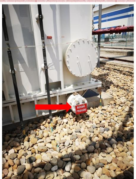
主变事故放油阀 盲板封堵未拆除, 操作手柄未到位
