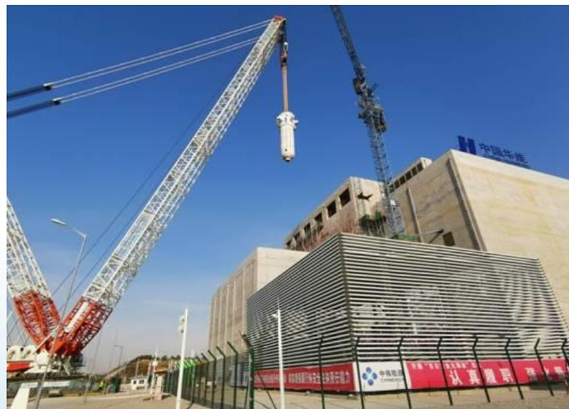
核电史上最大反应堆压力容器（直径约6.4m）穿越最小吊装间隙一次性精准就位。
