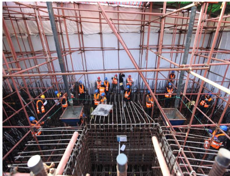
核岛筏板采用了整体跳仓法大体积混凝土浇筑技术和妥善的保温保湿养护技术，有效减少了地基对筏板的约束，防止了收缩裂缝的产生，确保了筏板的浇筑质量。
