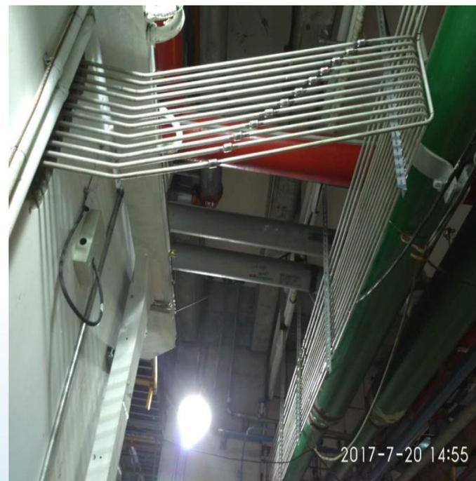
除盐水仪表管、二回路加药取样管标高、弯管角度一致，布置整齐美观。
