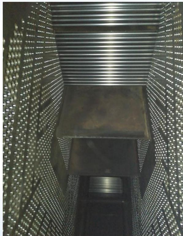
凝汽器钛管数量多（共6294根），分布密集。钛管隔板和管孔经清洁化处理，管壁内光洁，无锈蚀、毛刺、划痕、油垢、灰尘和杂物；钛管外观整洁。
