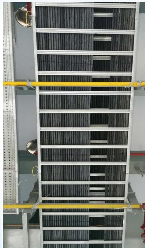
常规岛6.3米层垂直电缆敷设排列整齐、绑扎均匀、固定牢靠。
