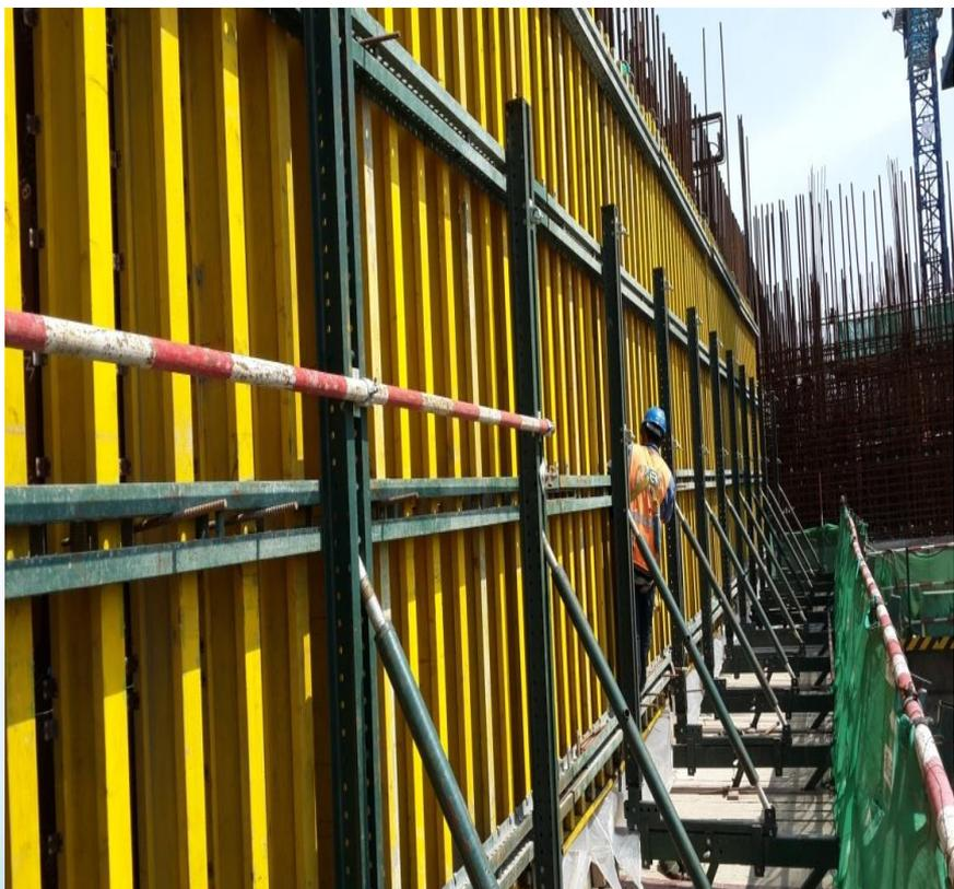
核岛清水混凝土施工模板体系选择合理。面板采用优质维萨模板，遇水不膨胀变形。连接系统的竖向背楞采用厚木工字梁，水平背楞采用双槽钢背楞，面板采用反钉法通过自攻螺丝和连接卡片与木梁固定连接，对拉螺栓用来保证模板体系的稳定性和承载力；模板支设体系选用“外挂架+清水模板”组合。通过外挂架后移装置进行清水模板支设，清水模板与已浇筑墙体內的爬锥锥体通过拉杆进行底部加固，上部通过对拉螺杆进行加固，并通过外挂架斜撑加固模板并调整模板垂直度。
