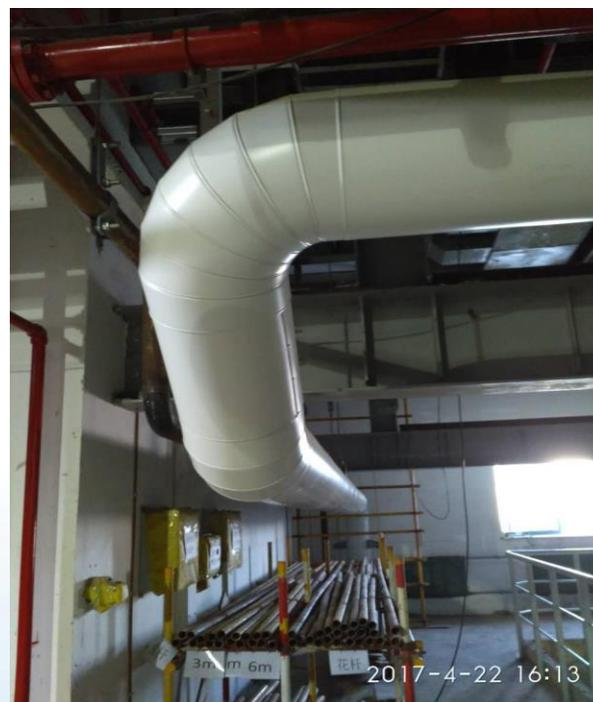
容器及管道保温层错缝、压缝搭接规范；表面光滑无凹痕，造型美观。
