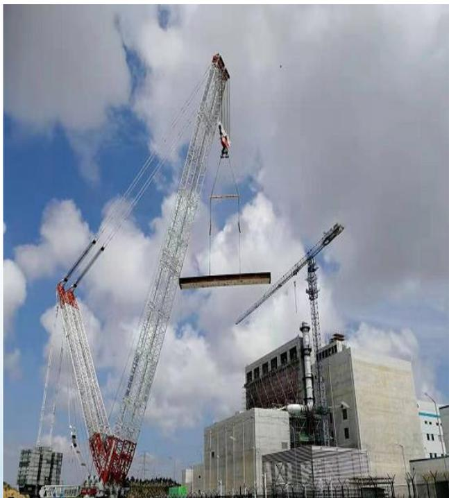
核岛厂房采用了长方形的大型钢混结构屋盖，以大型钢骨梁为主要受力结构，长44.8米、宽34.5米、厚度达2米。具有结构简单，模块化安装等特点。钢骨梁与周围结构的间隙小于9毫米。
