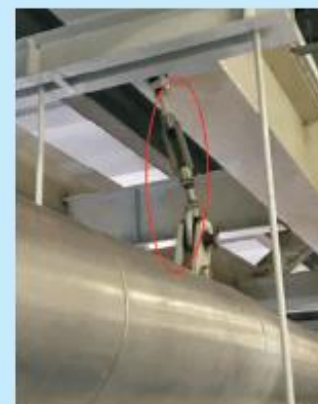
支吊架安装不规范，弹簧组件销钉未拔除，吊杆并帽未锁紧，部分吊架不受力、吊杆歪斜、膨胀受阻。
