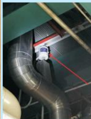
支吊架安装不规范，弹簧组件销钉未拔除，吊杆并帽未锁紧，部分吊架不受力、吊杆歪斜、膨胀受阻。
