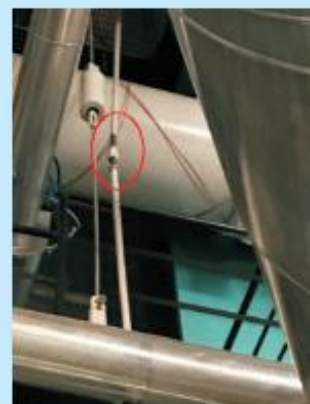
支吊架安装不规范，弹簧组件销钉未拔除，吊杆并帽未锁紧，部分吊架不受力、吊杆歪斜、膨胀受阻。
