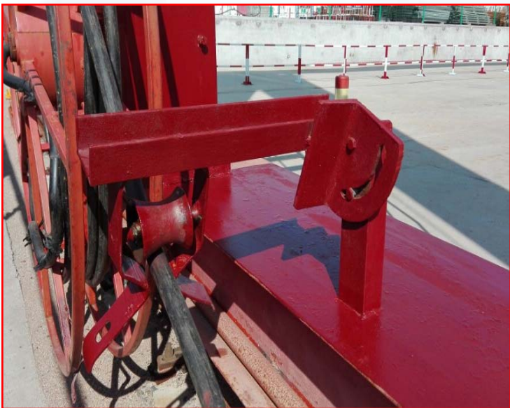
龙门吊电缆导线器良好实践
